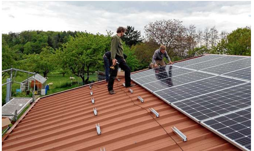
Die Installateure Wolfgang Striwe (links) und Friedemar Schreiber montieren im Mai 2017 Solarpanels für eine Fotovoltaik-Anlage auf dem Hausdach der Markdorfer Familie King. Karl King ist Koordinator des Markdorfer Sonnenkraft Netzwerks (MSN). BILD: KARL KING
