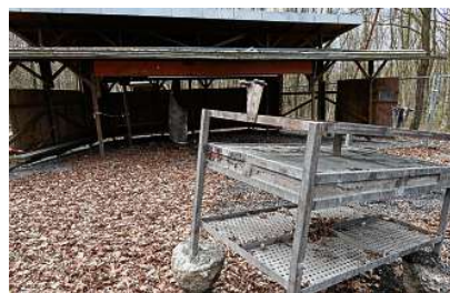
Mit den Arbeiten zur Umgestaltung der Grillhütte zur Waldhütte wurde bereits begonnen. So wurde der Grill aus dem Boden gelöst. BILD: GEORGE WEX
